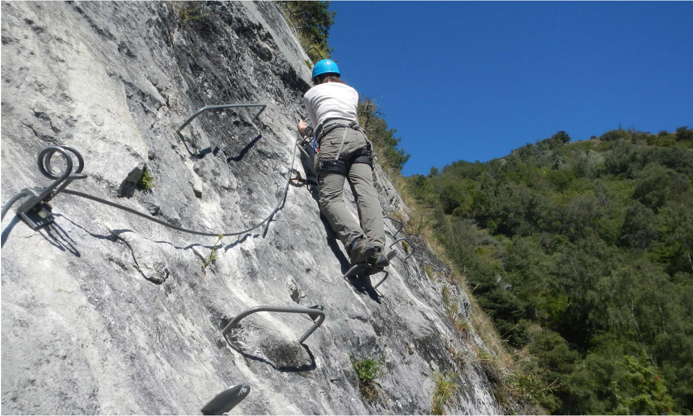
EN 1.4301 (AISI 304) 螺纹钢梯阶锚定到岩石中。
